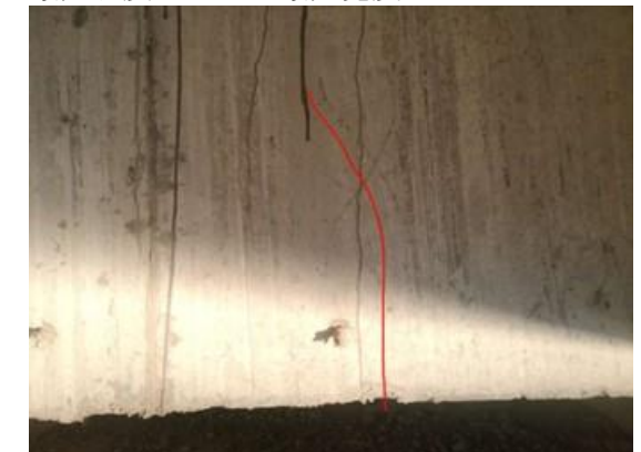
图 3-2：黄石高架桥右幅 43-5 小箱梁：距 42 号墩 6m 起，左翼缘板横向裂缝；数量：3 条，最大长度：0.5m，最大宽度：0.13mm。
