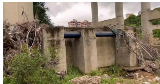
图 3-31: 萩芦大桥桥下集水井处改造维修加固
