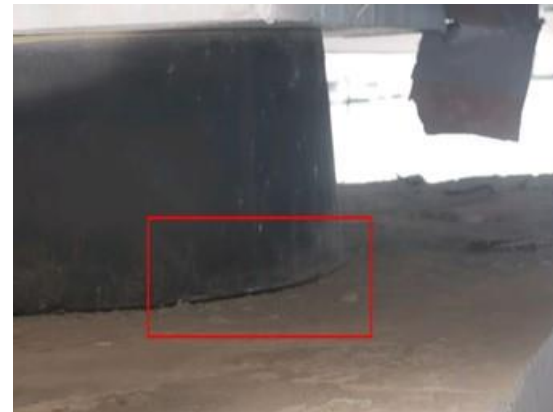
图 3-20: 江口高架桥右幅 ZZ-9-9-9 支座: 右侧脱空; 数量: 1 个, 高度: 0.005m, 百分比: 5%。
