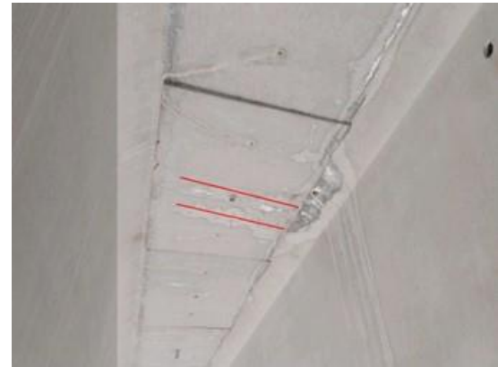
图 3-6: 黄石高架桥右幅 16-2S 湿接缝: 距 16 号墩 10m 起, 底面渗水; 数量: 2 处, 最大长度: 0.8m。
