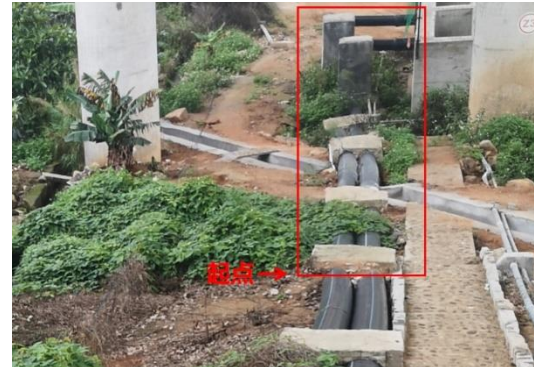
图 3-30: 月坪大桥桥下集水井处改造维修加固
