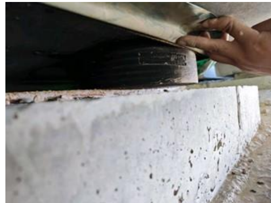
图 3-17: 黄石高架桥左幅 ZZ-9-8-8 支座: 往大桩号侧; 数量: 1 个, 位移: 0.15m。
