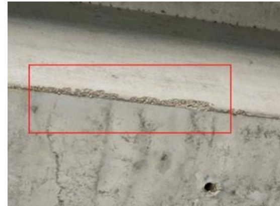
图 3-5: 黄石高架桥左幅 22-1 小箱梁: 距 21 号墩 4m 处, 梁底剥落、掉角; 数量: 1 处, 长度: 1.3m, 宽度: 0.1m。
