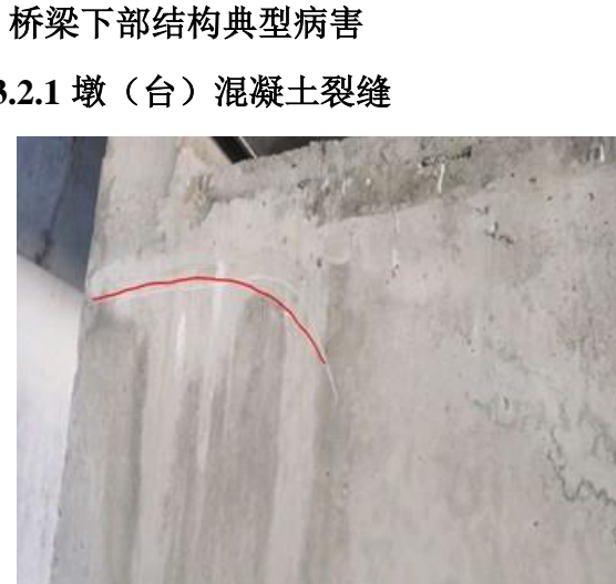
图 3-9: 黄石高架桥左幅 GL-52D 盖梁: 距右侧 0m 处, 大桩号面横向裂缝; 数量: 1 条,
