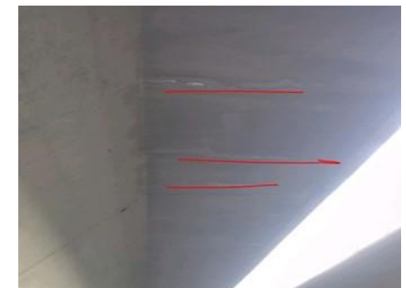
图 3-2：黄石高架桥右幅 43-5 小箱梁：距 42 号墩 6m 起，左翼缘板横向裂缝；数量：3 条，最大长度：0.5m，最大宽度：0.13mm。
