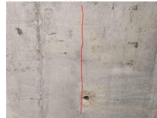
图 3-1：黄石高架桥左幅 121-2 小箱梁：距 120 号墩 0m 处，右翼缘板斜向裂缝；数量：1 条，长度：1m，宽度：0.13mm。
