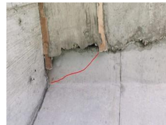
图 3-1：黄石高架桥左幅 121-2 小箱梁：距 120 号墩 0m 处，右翼缘板斜向裂缝；数量：1 条，长度：1m，宽度：0.13mm。
