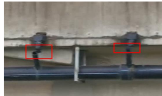
图 3-26: 雨水斗与竖向排水管连接处脱节
