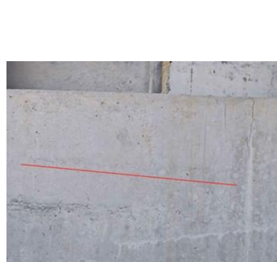
图 3-10: 黄石高架桥右幅 GL-62D 盖梁: 距上缘 0.3m 处, 右侧挡块纵向裂缝; 数量: 1
