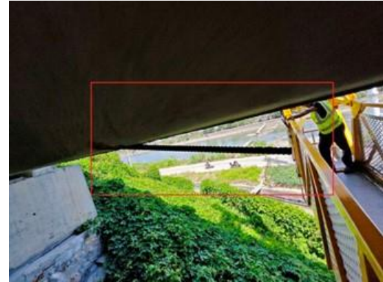
图 3-8: 江口高架桥右幅 50-1 小箱梁: 距 50 号台 6m 处, 梁底露筋; 数量: 1 处, 长度: 0.4m, 宽度: 0m。
