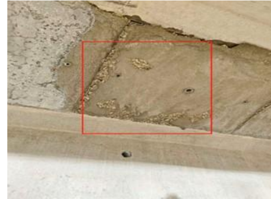
图 3-7: 江口高架桥左幅 16-4S 湿接缝: 距 16 号墩 13m 处, 底面蜂窝、麻面; 数量: 1 处, 长度: 0.1m, 宽度: 0.4m。
